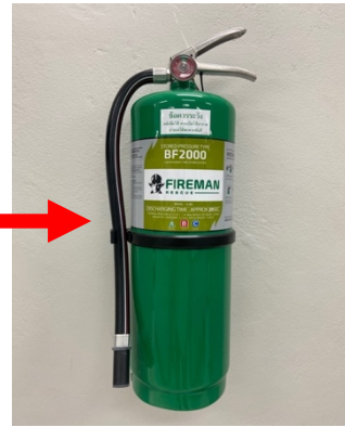
ภาพที่ 3.12 วิธีการตรวจสอบถังดับเพลิงเบื้องต้น
